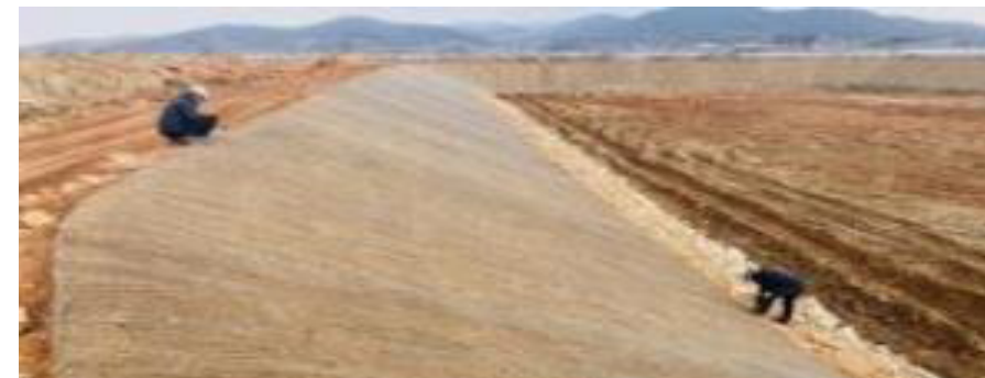
[에너지밸리 호안공사(스톤네트공법 - 생태복원 매트리스공법 적용)]
